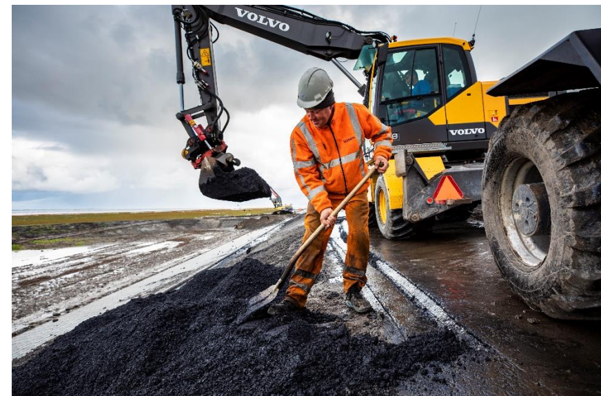
Figuur 4 Lauwersmeerdijk - asfaltering buitentalud
