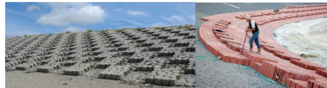
Links dambordpatroon van Basalton op de Hondsbossche Zeewering en rechts patroon van Hydroblock bij Breskens en Hillblock bij Zierikzee.
